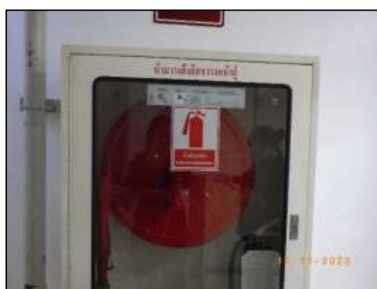
รูปที่ 2-22 ตู้เก็บสายฉีดน้ำดับเพลิงพร้อมอุปกรณ์
