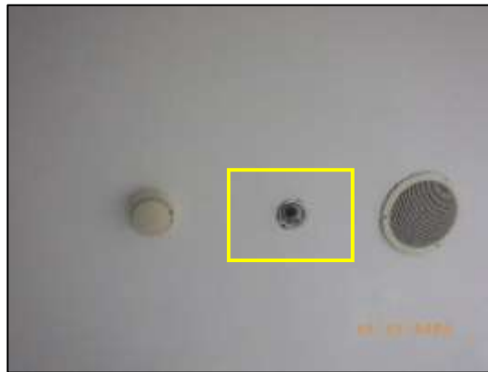
รูปที่ 2-24 ระบบดับเพลิงอัตโนมัติ
